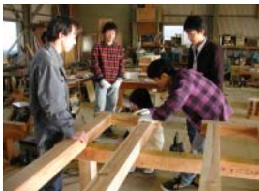
写真-2 樋柱の組立て状況
