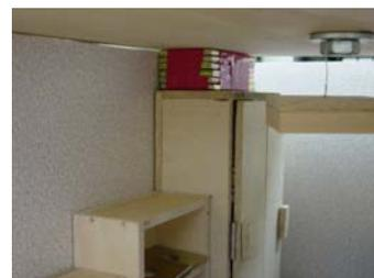
写真4 天井の隙間を錘で補強
